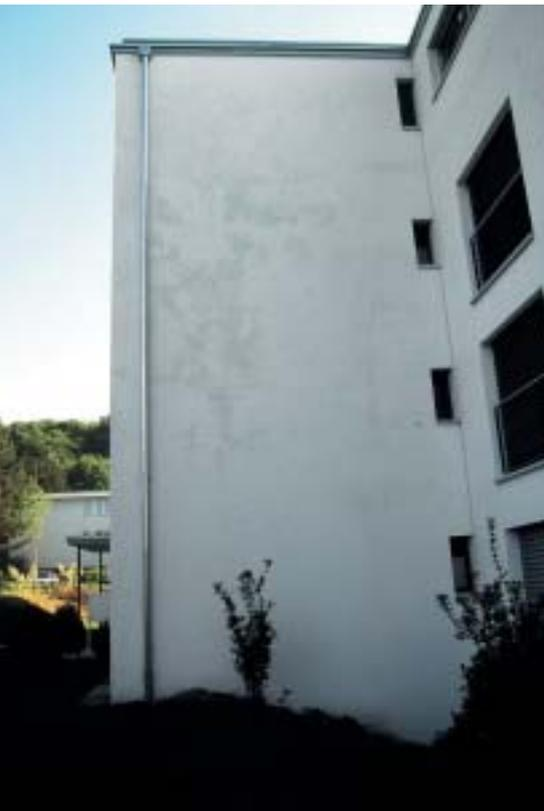
1 Gelbe Verfärbungen auf einer neuen Vollwärmeschutzfassade, hervorgerufen durch eisenhaltige Sande im Klebemörtel
