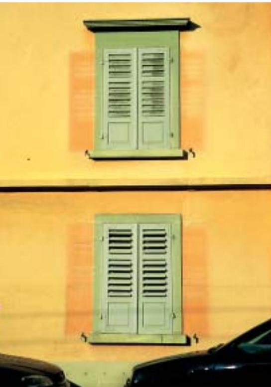
9 Farbtonveränderung einer orangefarbenen Dispersion durch Abbau des Rotanteils
