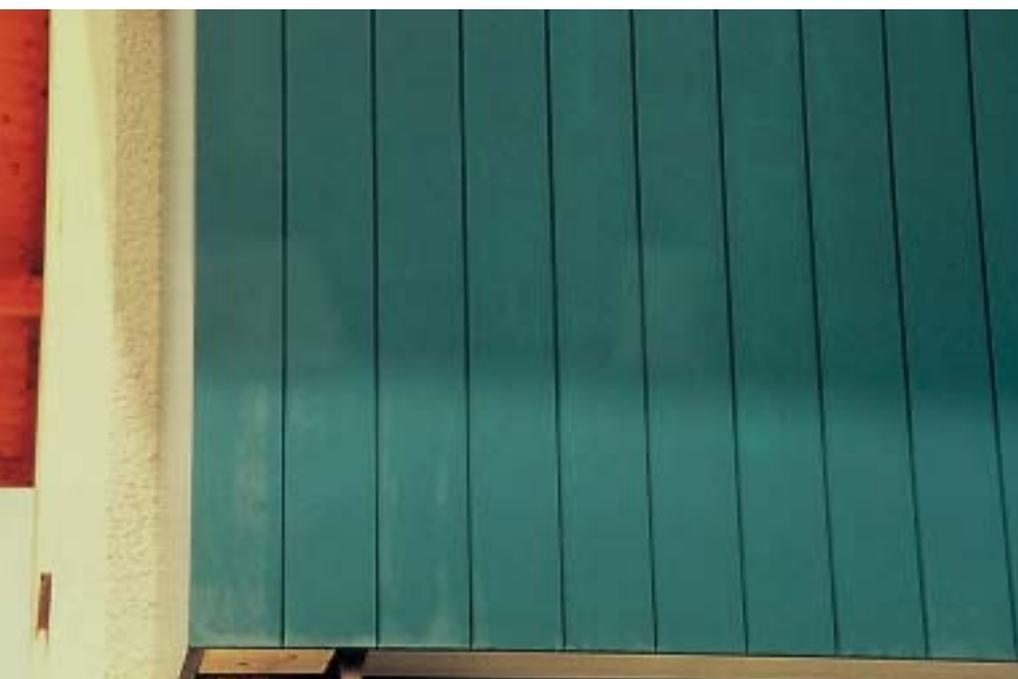
12 Farbtonveränderung durch Zerstörung des Gelbpigmentes in einem Acryllack durch alkalische Duripanelplatten
