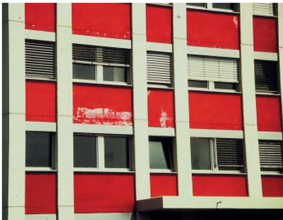
10 Farbtonveränderung durch Verwendung von Bleimolybdat auf Beton
